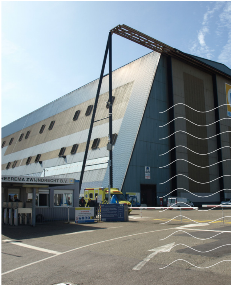
Veel ruimte op daken beschikbaar voor zonnepanelen
