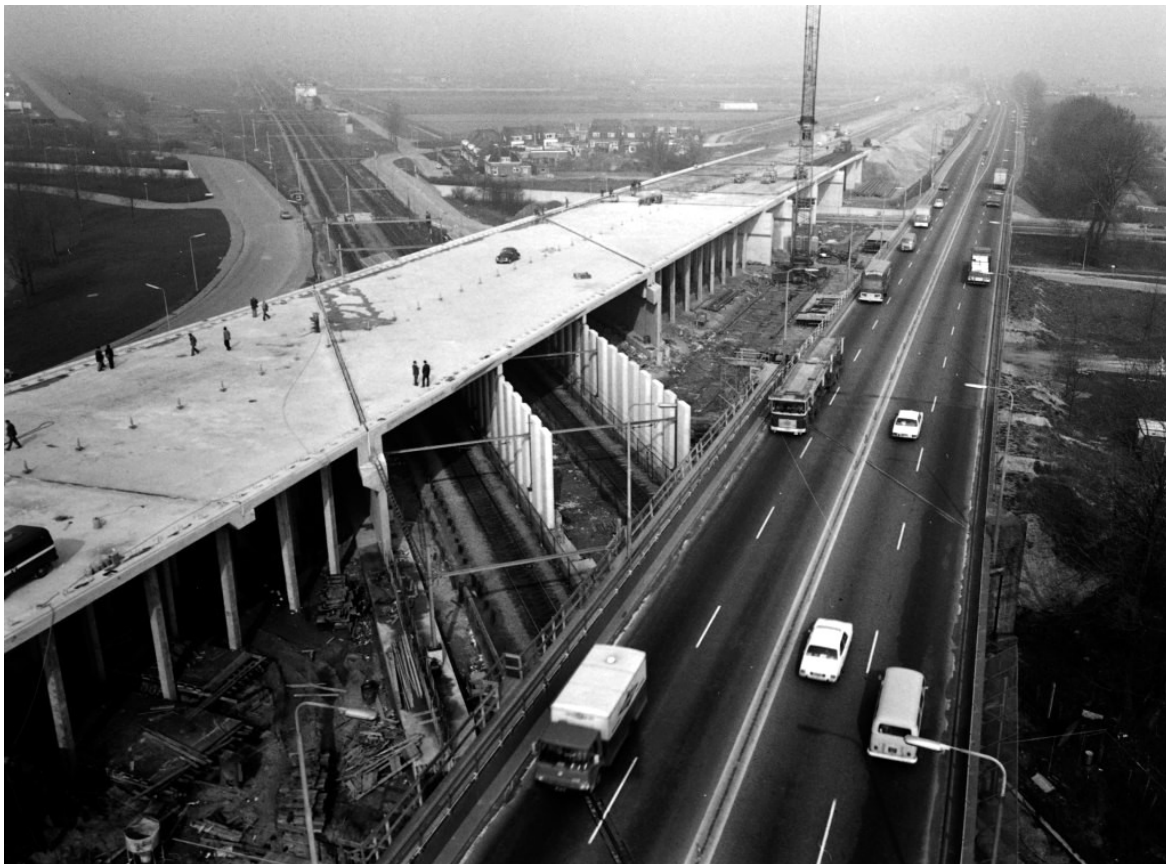
Het viaduct van de A16 in aanbouw in 1974, met rechts de oude rijksweg
